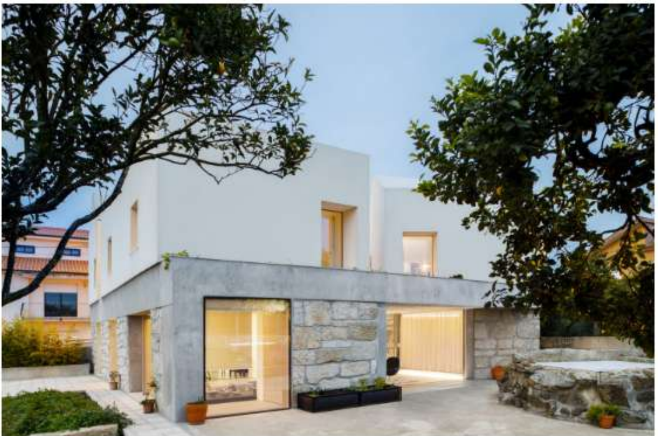
Projeto residencial Casa do Rio / Cortesia Paulo Merlini Architects
