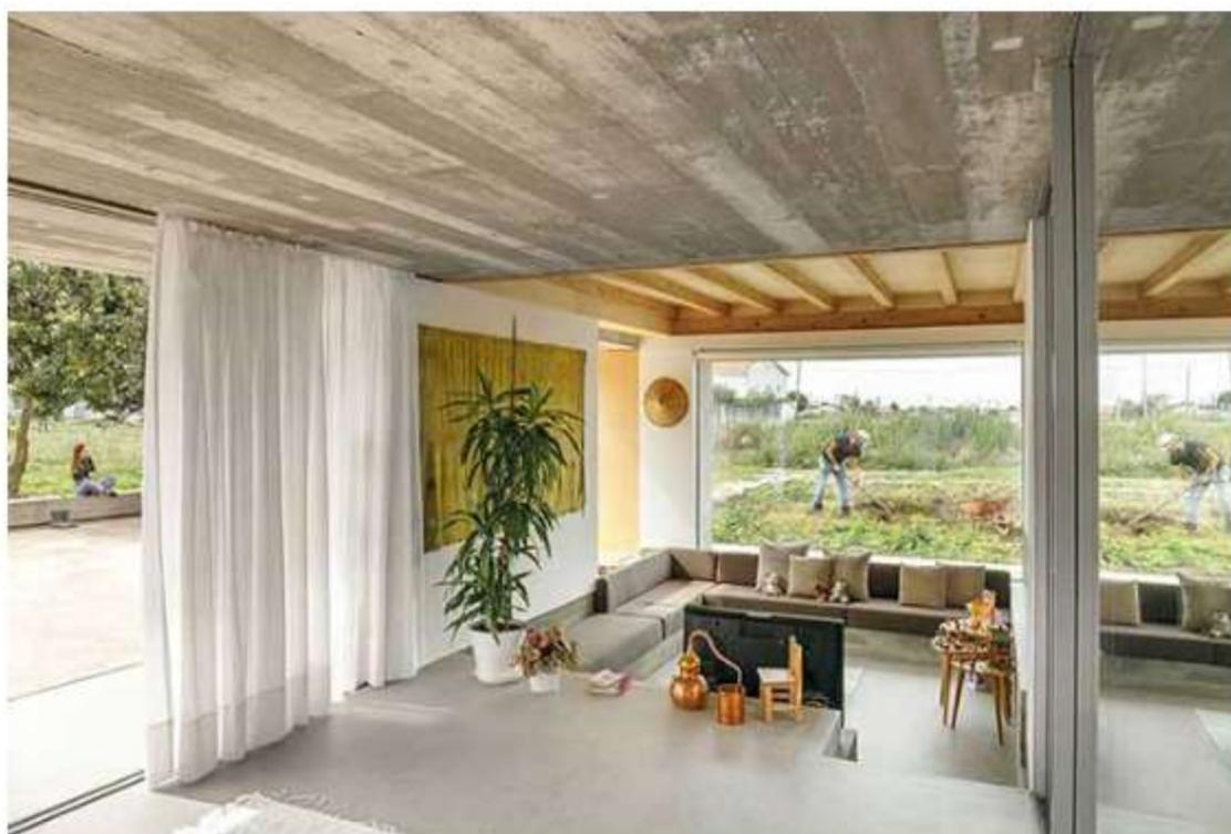
**I materiali scelti rinforzano la matrice del progetto attraverso il contrasto cromatico** (grigio e bianco), ma soprattutto materico: al piano terreno la ruvidità del cemento a vista denuncia la tettonica della costruzione, in costante relazione con il granito e con la sensazione di vivere in uno spazio 'scavato', grazie alla relazione visiva con il verde esterno. Le ampie vetrate scorrevoli permettono, nei mesi più caldi, di estendere gli ambienti all'esterno.
